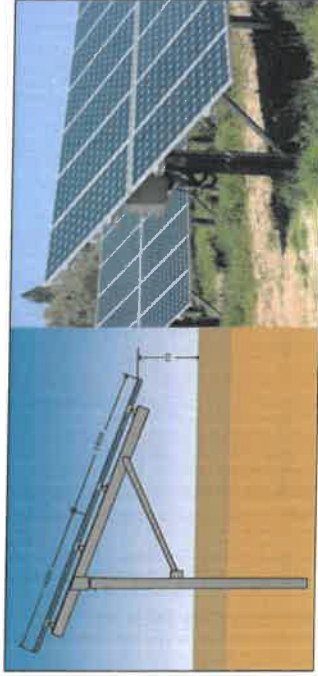
Figure 90 : Supports, fondations vissées et panneaux photovoltaïques
